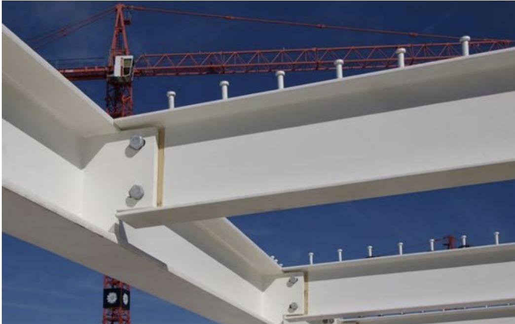
Träger mit Brandschutzbeschichtung auf Epoxidbasis
